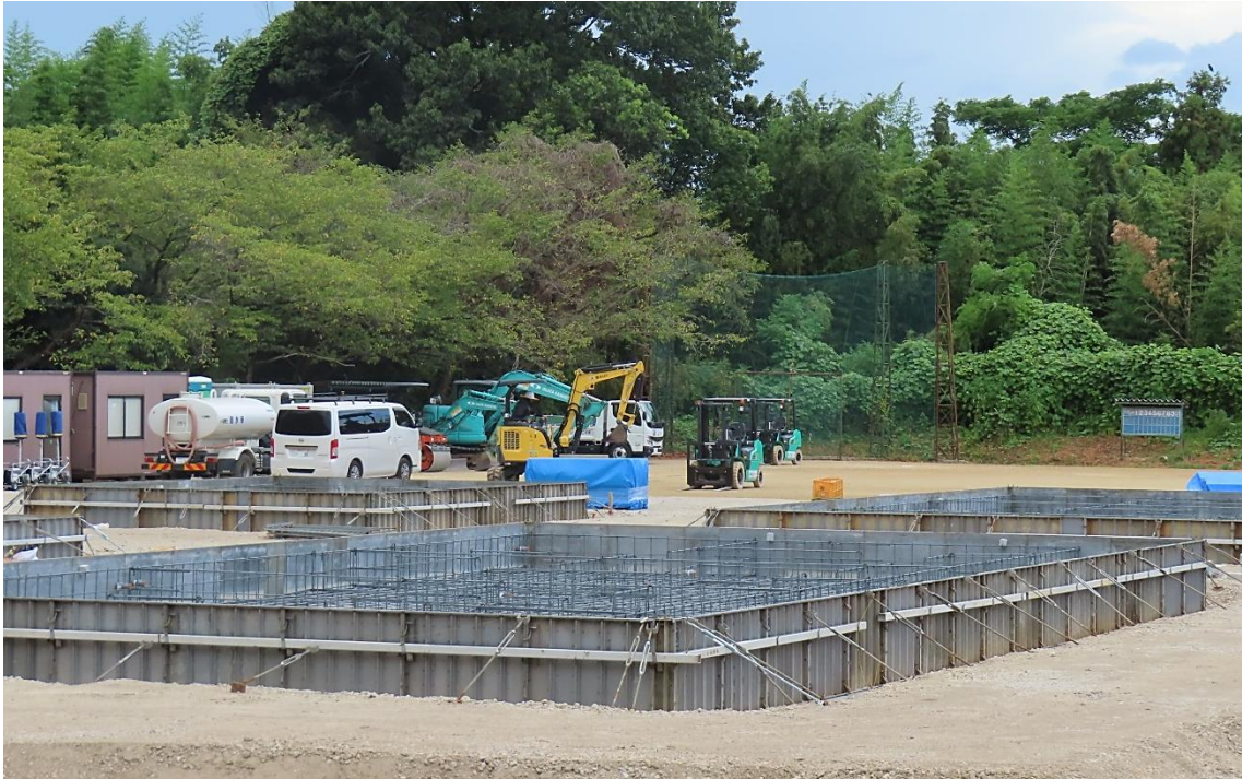
仮設住宅の建設が始まった当尾仮設団地＝宇城市松橋町の当尾グラウンド
