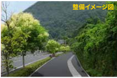
▲国道10号別大地区電線共同溝事業
