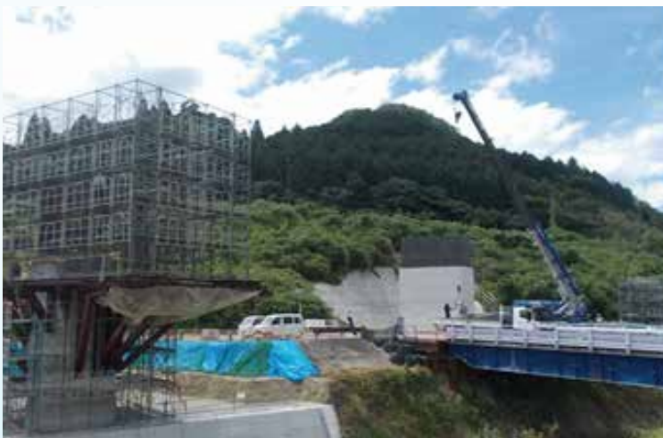
▲国道212号三光本耶馬溪道路施工状況
