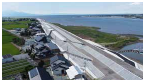
▲緑川河口域の高潮堤防(T.P.6.0m)
