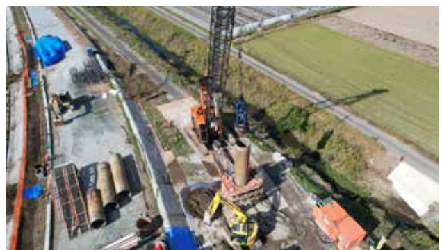
▲大津熊本道路(上生(わぶ)川橋下部工工事)
