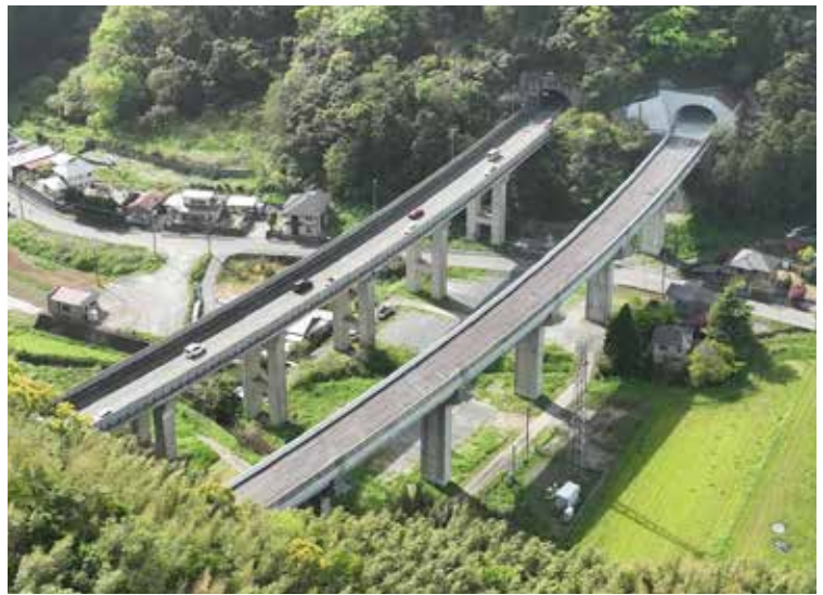
▲国道3号岡垣バイパス 上畑高架橋の施工状況 (R5年4月)
