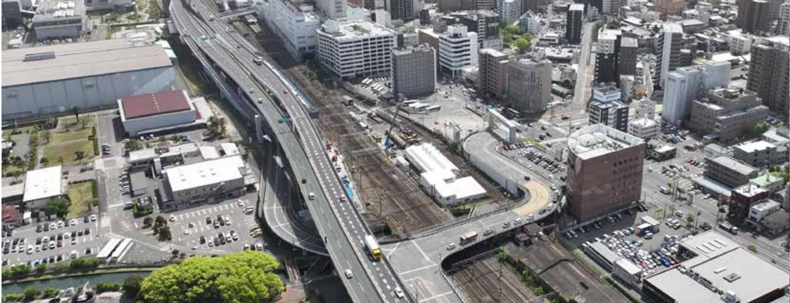
▲国道3号黒崎バイパス 黒崎西ランプの施工状況(R5年4月)
