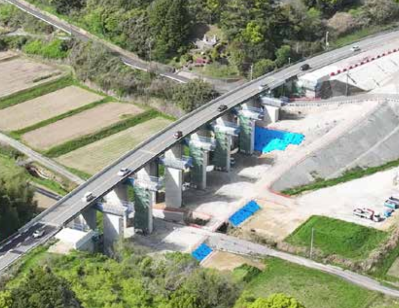
▲国道201号八木山バイパス 本谷高架橋の施工状況 (R5年4月)
