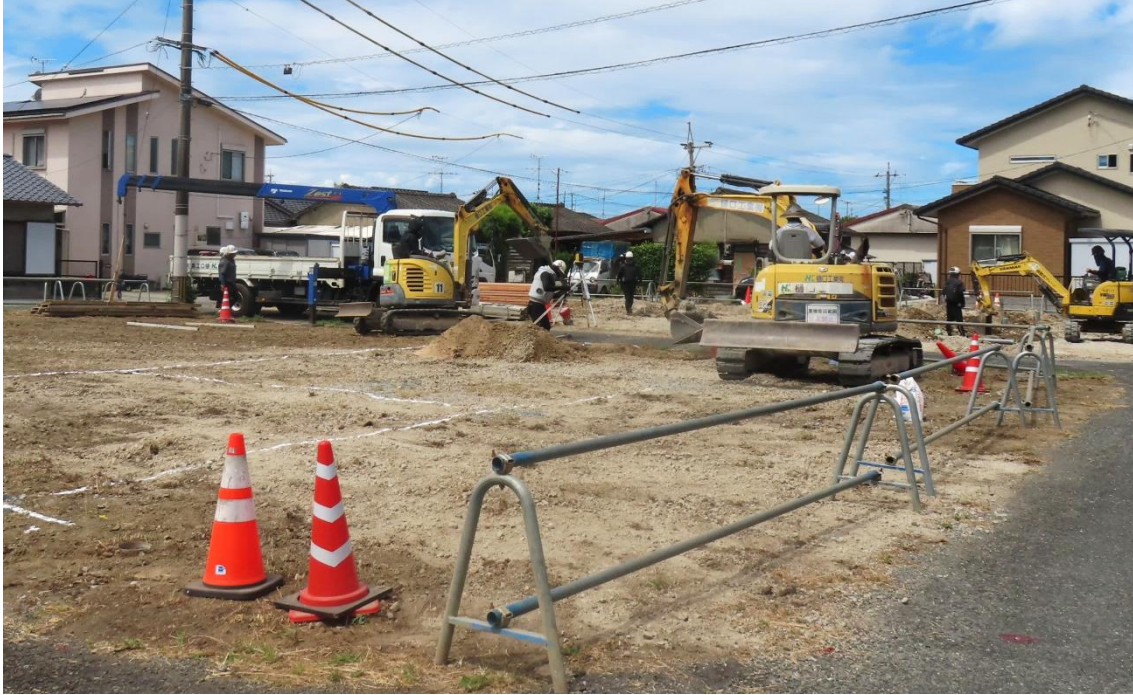
氷川町に追加整備される県内初の2階建て仮設住宅（軽量鉄骨造）の建設現場
