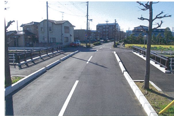
ジョイントレス構造施工例
