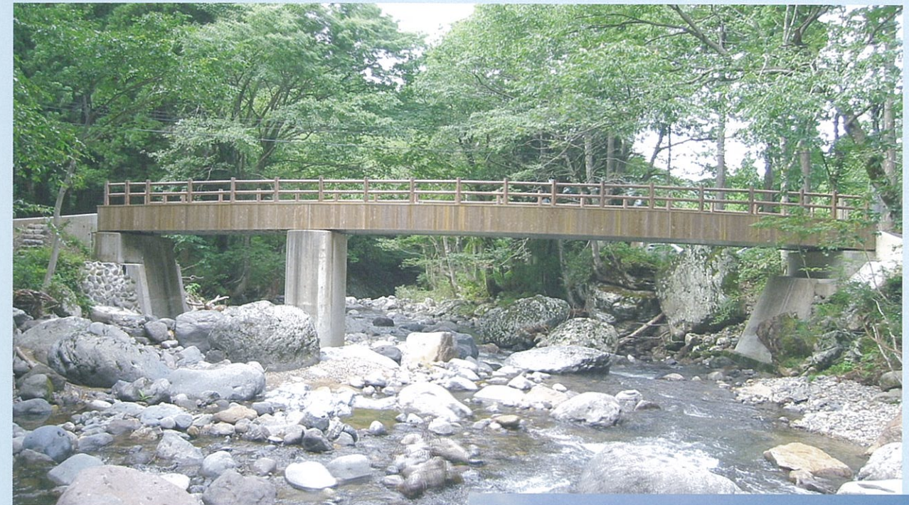
久保橋上部工架替工事 橋長24.80m(7.40+17.40) 石川県小松市(平成16年5月架)
