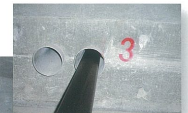
横桁通過状況
