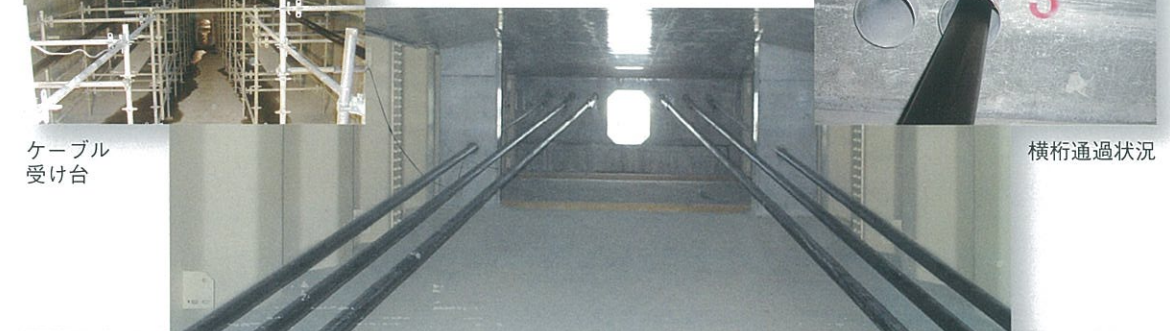
桁内配置状況
