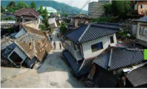
▲熊本地震被災直後の益城町市街地の様子
