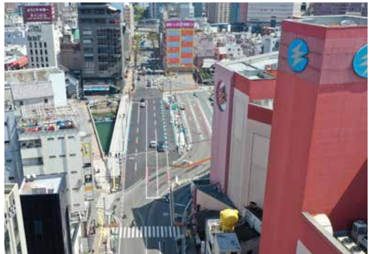
▲完成した春吉橋（天神側から）
