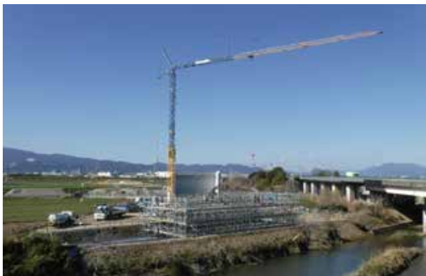
▲九州で初めて定置式水平ジブクレーンを用いた試験施工
