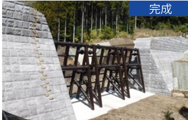
▲四ツ江川砂防堰堤
