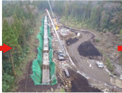
▲Ⅰ期工事：令和元年7月～令和2年3月
