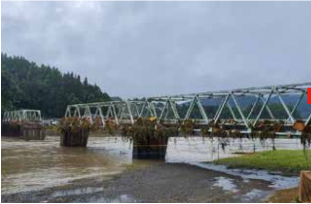
被災した西瀬橋
