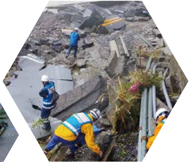
▲災害復旧工事
