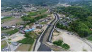
▲応急復旧状況
