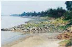
▲建設中の水制群（2002年）
