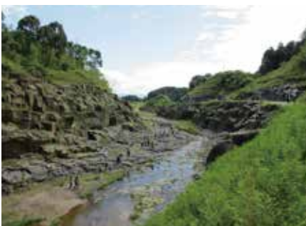
▲曾木の滝分水路 下流側より (h24. 曾木はっけんウォーキング開催時)
