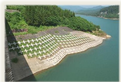
永久アンカー工法
