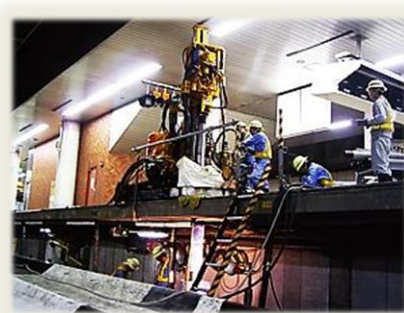
高被圧水下アンカー工法
