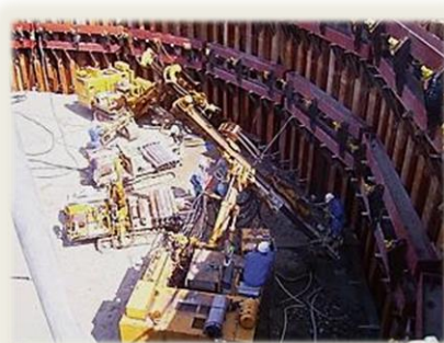
仮設アンカー工法
