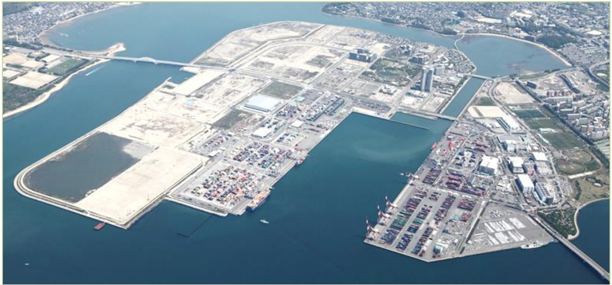
開発が進む博多港アイランドシティ地区
