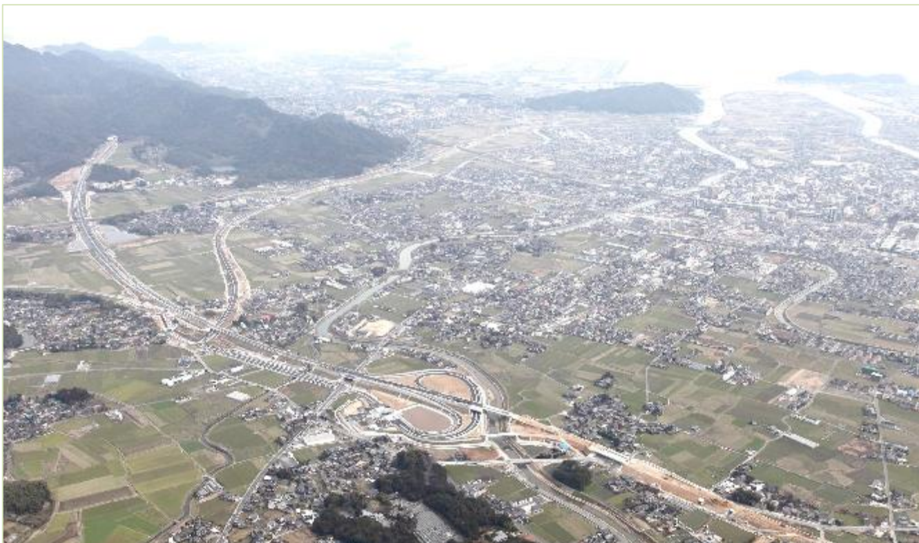
H26.3 撮影：『東九州自動車道と国道201号行橋インター関連開通状況』
